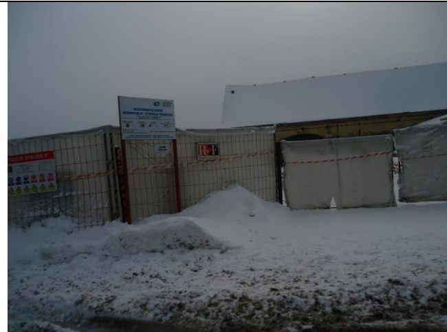
V době KD y technologická přestávka – nepřízeň počasí. Stavba zabezpečena před vstupem nepovolaných osob.
