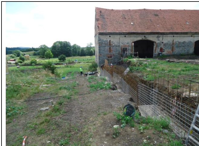
Oplocení staveniště pevným plotem dle požadavku plánu BOZP. Vyvěsit oznámení na OIP.
