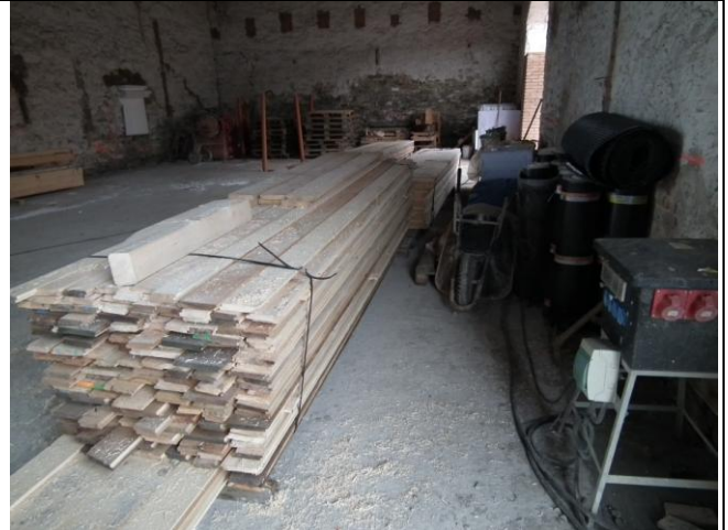
Skladovaný materiál je zajištěn proti sesuvu a pádu zapáskováním. Bez připomínek.
