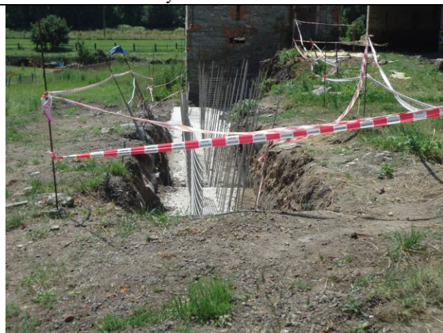
Pracovní jámy – otvory zabezpečeny.
