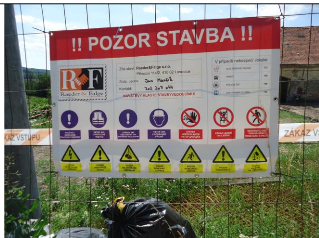
Značení staveniště výstražnými nápisy a piktogramy po celém obvodu stavby. Důležitá tel čísla uvedena.
