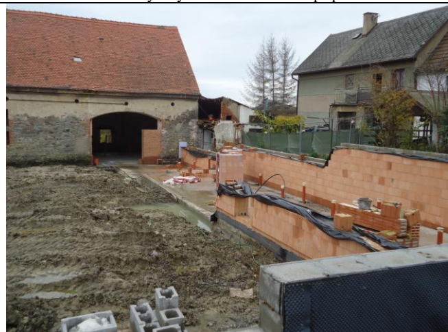
Práce jsou prováděny dle odsouhlaseného plánu BOZP a technologických postupů. Bez připomínek.
